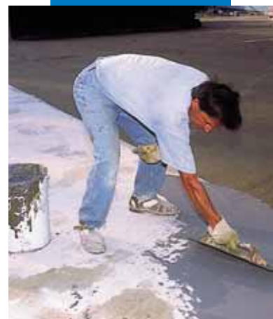
Impermeabilizzazione di una piscina con Mapelastic
