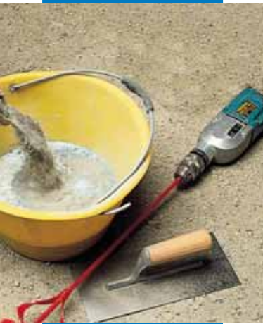
Impasto di Mapelastic con agitatore meccanico
