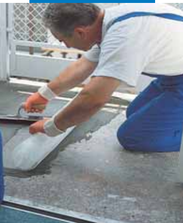
Impermeabilizzazione di un balcone con Mapelastic con applicazione di Mape-net 150
