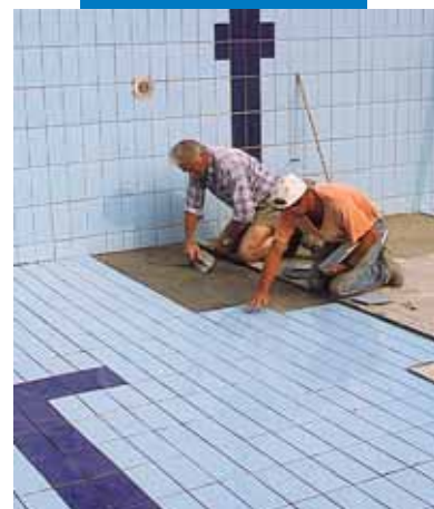
Posa di rivestimento ceramico su Mapelastic
